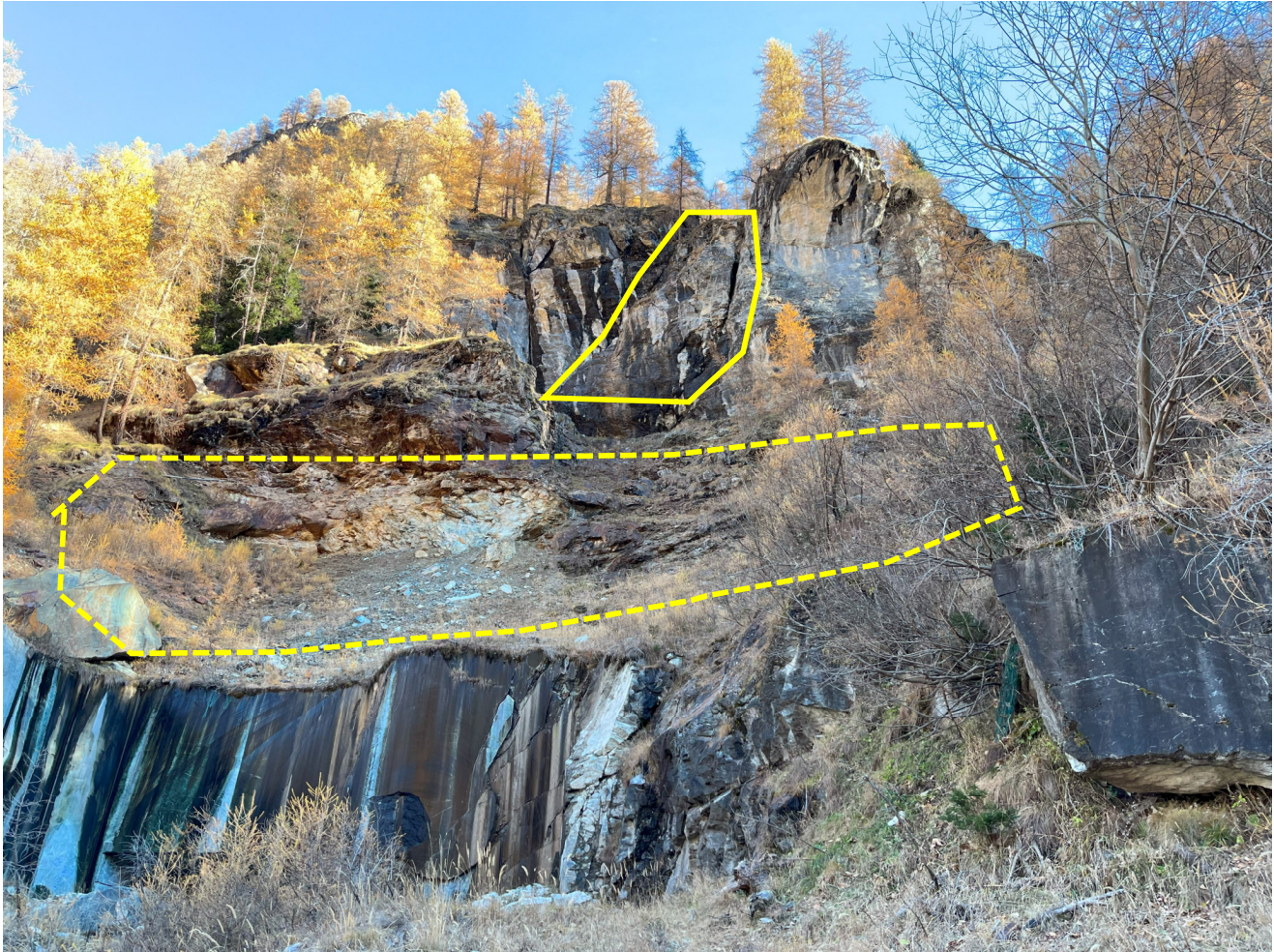
Fig. 29: la zona messa in evidenza dalla linea gialla mostra la zona di intervento di consolidamento preventivo sulla massa verso la sommità del crinale.
